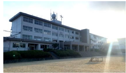
改修完成間近の北館校舎
